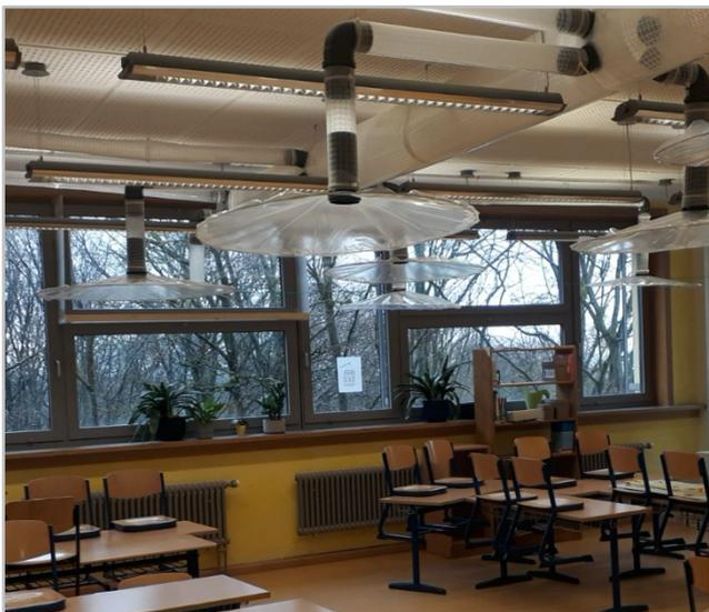
„38 Personen haben in unzähligen Arbeitsstunden 143 Ablufthauben installiert, 550 Meter Schlauch zugeschnitten und zu 297 Rohren verarbeitet.“ Damit werden die Aerosole aus den Räumen geleitet und so das Stoßlüften zum Schutz vor Corona ergänzt.
